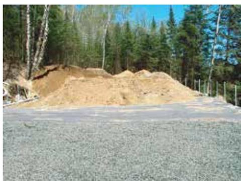
Avant d'être remblayée, la superficie de pierre devrait être recouverte d'une membrane de séparation telle l'Aérotex afin de faciliter l'évapotranspiration et le transfert d'oxygène aux tranchées d'absorption. Il est important de laisser l'oxygène pénétrer dans le sol. Les micro-organismes qui digèrent les déchets ont besoin d'oxygène pour survivre et fonctionner.
